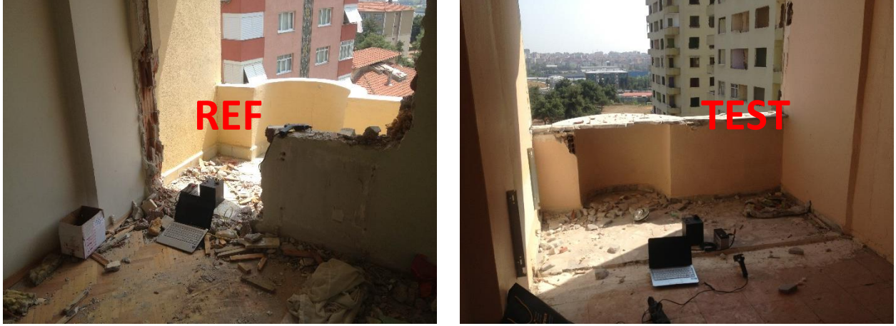
Şekil-6- Sensör yerleşim noktaları, Solda referans REF binası, Sağda TEST binası, her iki binada sensörler 6.kata, kat planı üzerinde aynı noktalara, ana eksenine GÜNEY yönüne bakacak şekilde yerleştirilmiştir.
