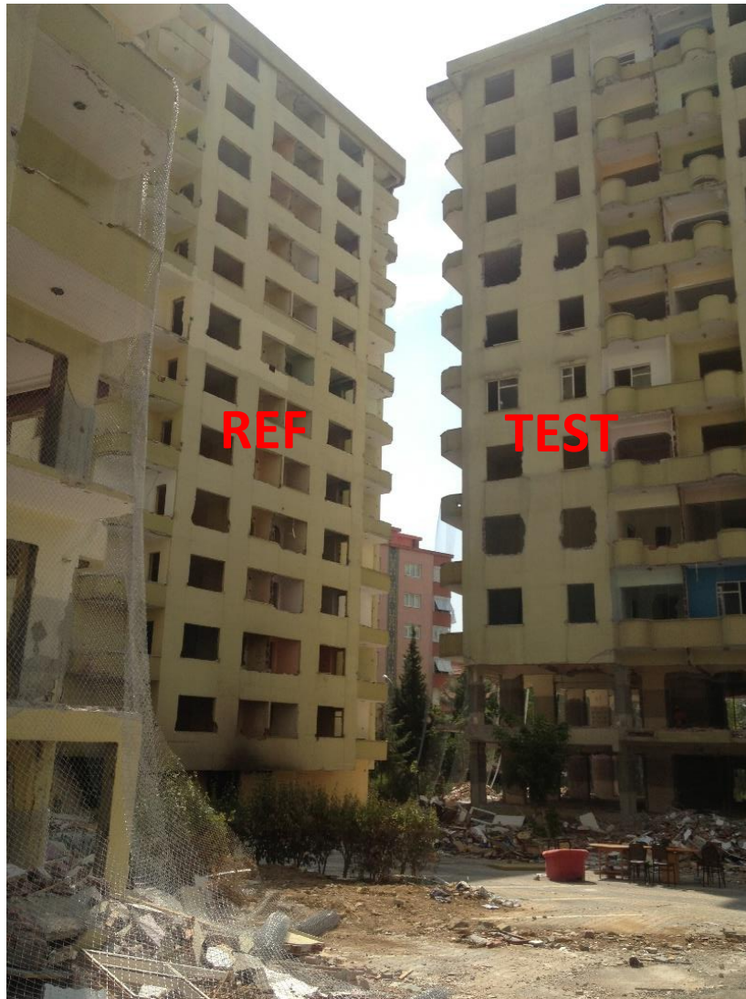
Şekil-3- Aralarında karşılaştırma yapılmasına karar verilen 2 bina (Soldaki-minimum hasarlı, Sağdaki – alt 2 katta önemli miktarda yumuşatma çalışması yapılmış)
