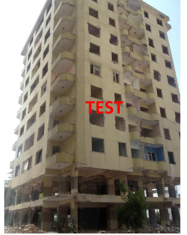
Şekil-4- Aralarında karşılaştırma yapılmasına karar verilen 2 bina (Soldaki-minimum hasarlı, Sağdaki – alt 2 katta önemli miktarda yumuşatma çalışması yapılmış)
