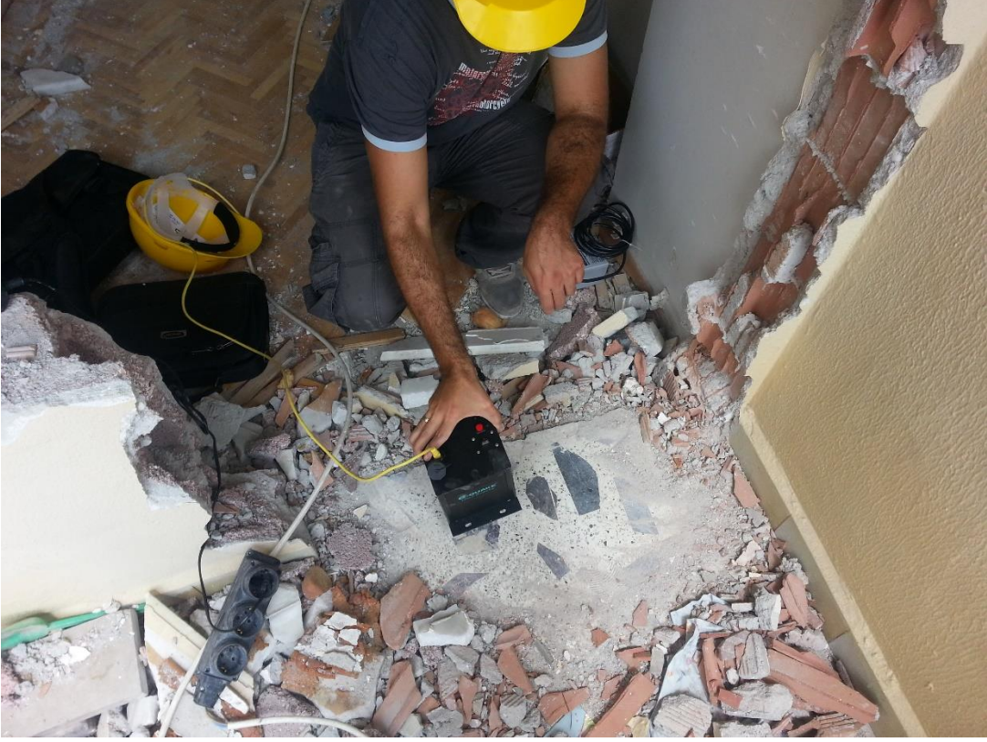
Şekil-8- Sensörlerin silikonla yapıştırılması
