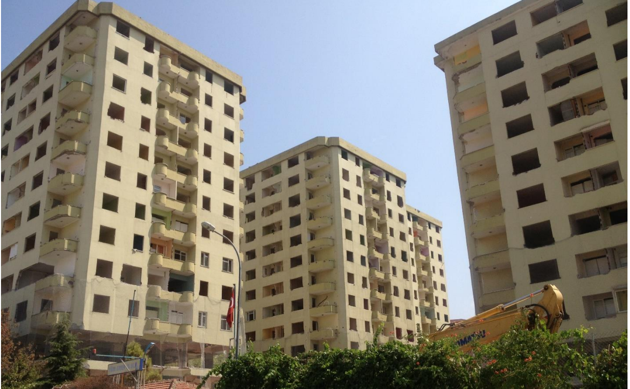
Şekil-2- Deneysel çalışmanın yürütüldüğü Emek-İş Blokları Sitesi
